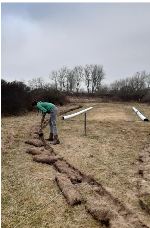
Figuur 4. Gijsbert Twigt graaft een kabelsleuf voor de aanleg van een nieuwe geluidsinstallatie.
