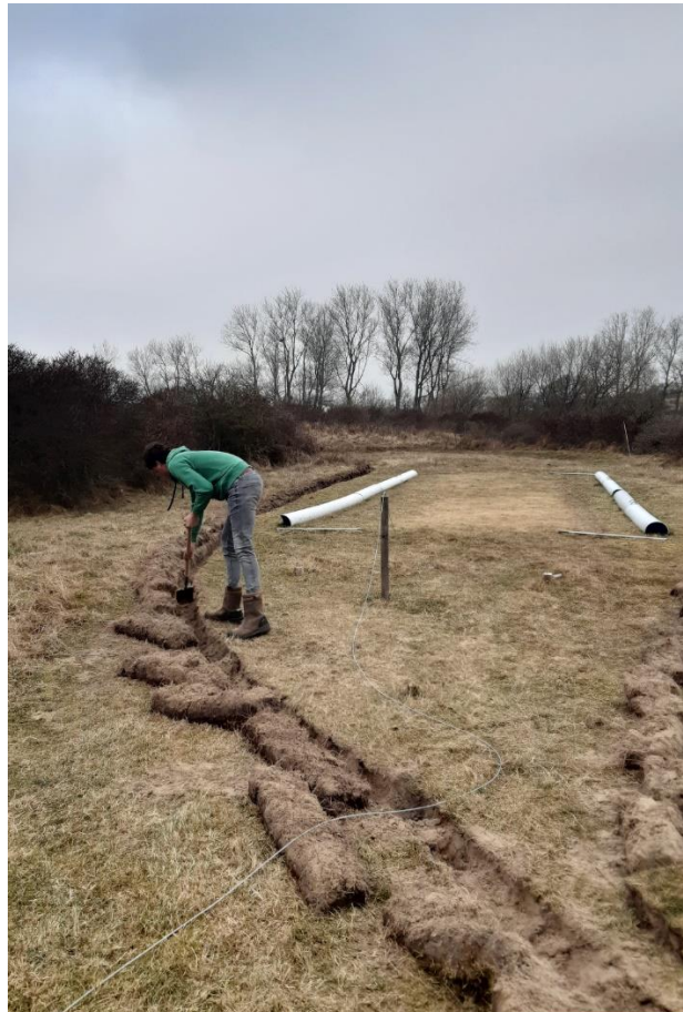
Figuur 3. Gijsbert Twigt graaft een kabelsleuf voor de aanleg van een nieuwe geluidsinstallatie.
